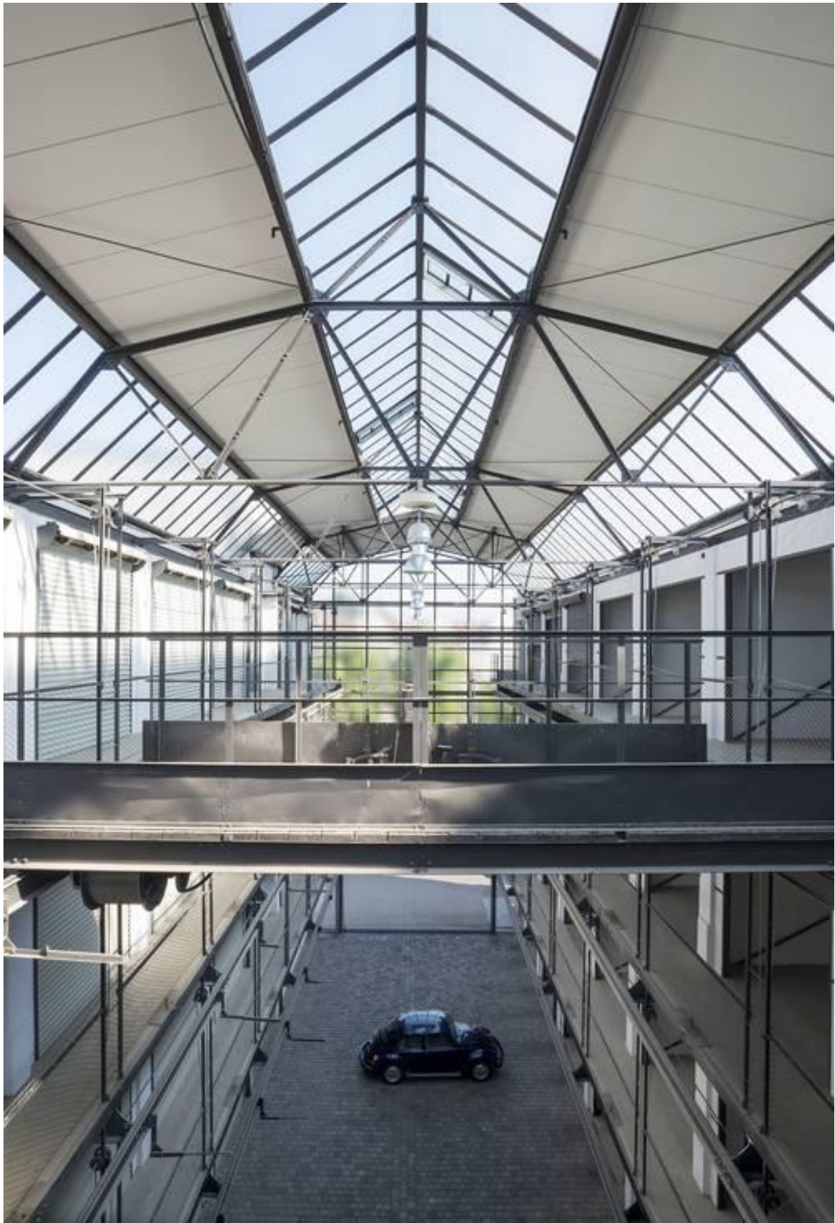
Blick in die Großgarage Pfännerhöhe in Halle (Saale), Foto: Andrea Hörentrup, (c) LDA Sachsen-Anhalt
